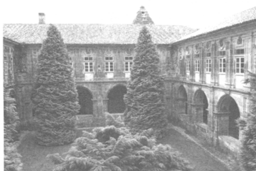
Obras de reconstrucción Claustro en la actualidad
