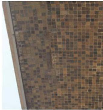
Figura 160. Goterón introducido en encuentro entre el vitraico y plano de fachada en el año 1997 por Llinás. Santiago Barge.
