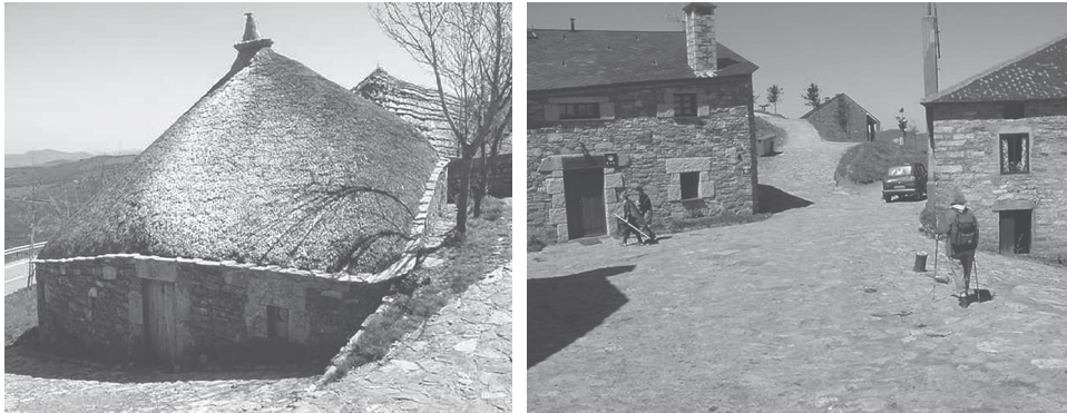
Fotos 8.7. y 8.8. Estado actual de construcción típica denominada "Palloza". Paredes de piedra granítica con techumbre de lajas de pizarra y superpuesto entrelazado de paja. Se encuentra en la zona urbana de O Cebreiro, entre construcciones actuales (izquierda). Pequeña plaza de O Cebreiro: con construcciones rehabilitadas manteniendo su origen y con suelo empedrado con piedras de granito (derecha).
