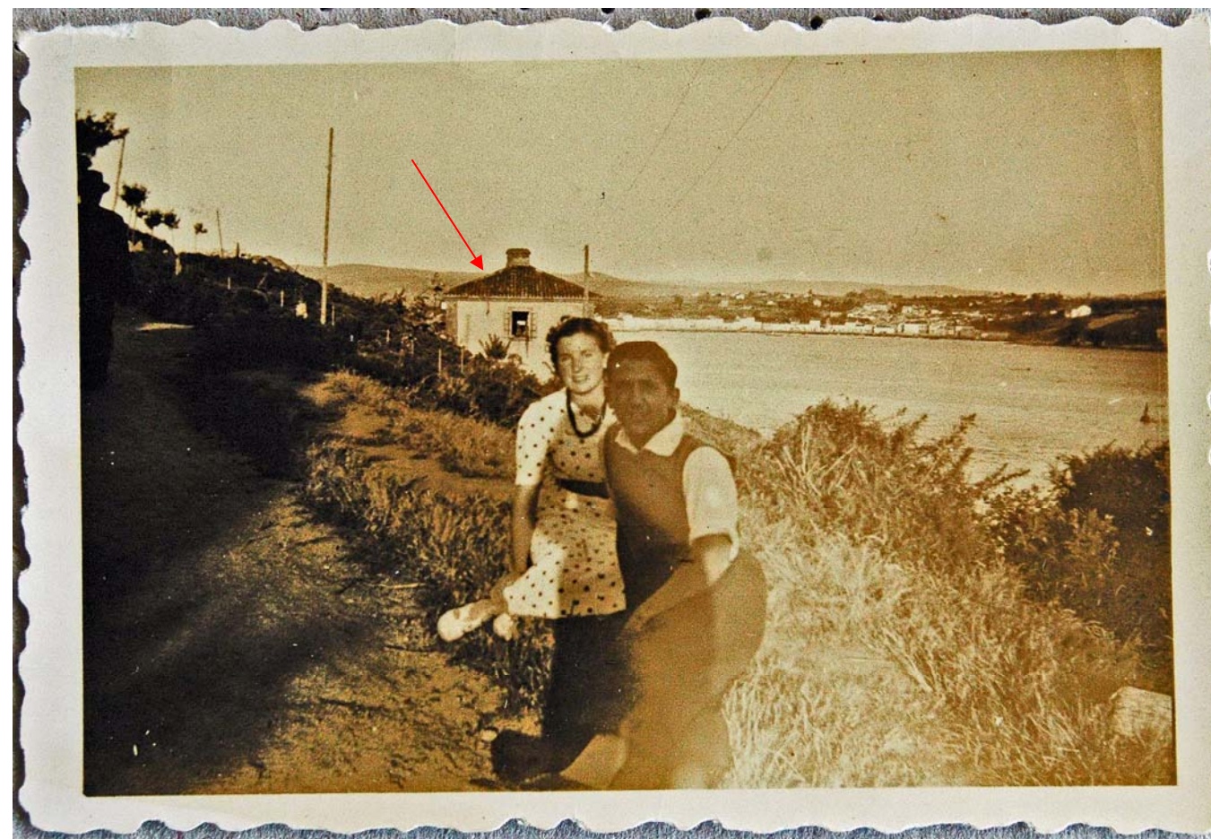
Fotografía de 1933 (fondo privado de D. José Naya Vega): vista del edificio del “Cuerpo de Guardia” desde el Oeste, en el que se puede observar el faldón de cubierta hacia este alzado, que culmina en la chimenea.
