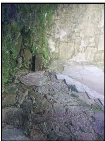
Foto 4 - Restos de escaleras de fábrica de piedra
