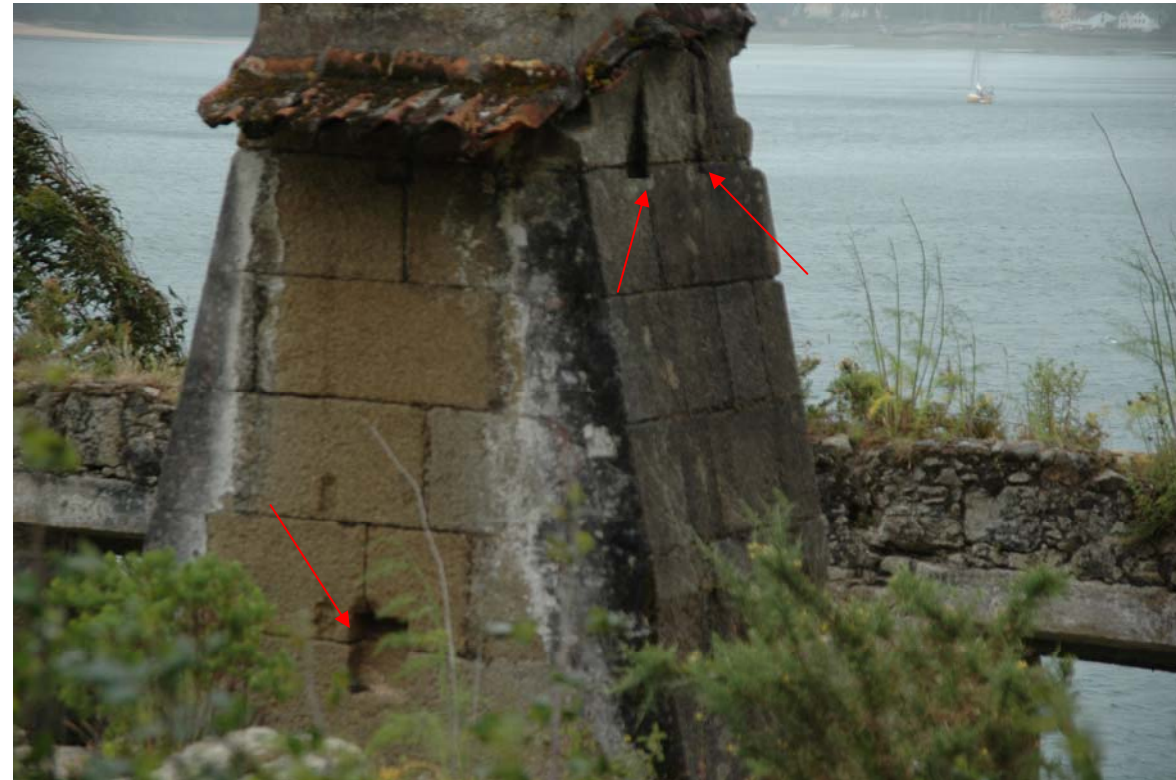
Detalle de entalladuras en la estereotomía de la chimenea para poder alojar los pares y semicerchas que le transmitían el peso de parte de la cubierta.
