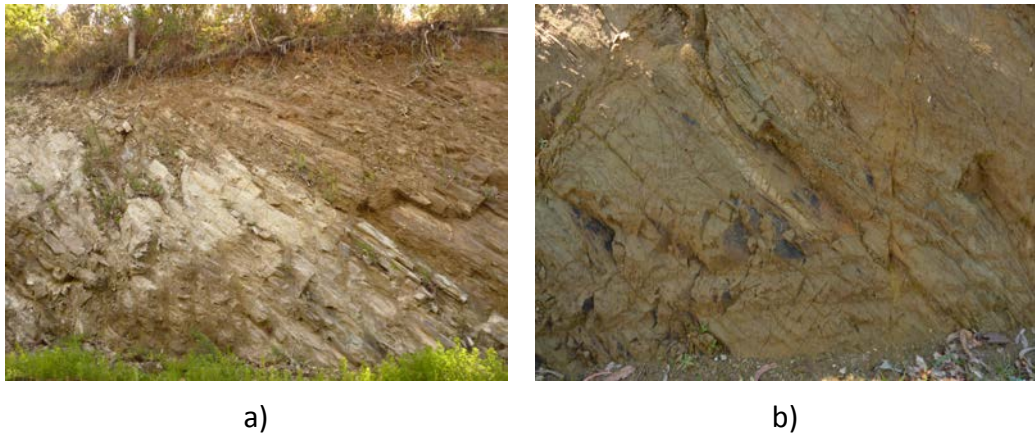
Figura 4.5. Esquistos en fase avanzada de alteración (especialmente b) en la cuenca del río Corbeira.
