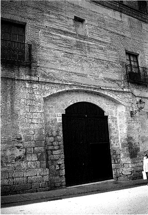
Figura 2 Puerta principal sin terminar
