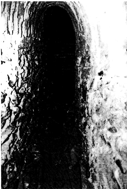
Figura 1 Galería de captación. Caño de Santa María
