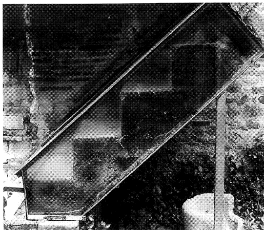
Figura 12 Escalera de madera de peldaños macizos. Detalle de arranque
