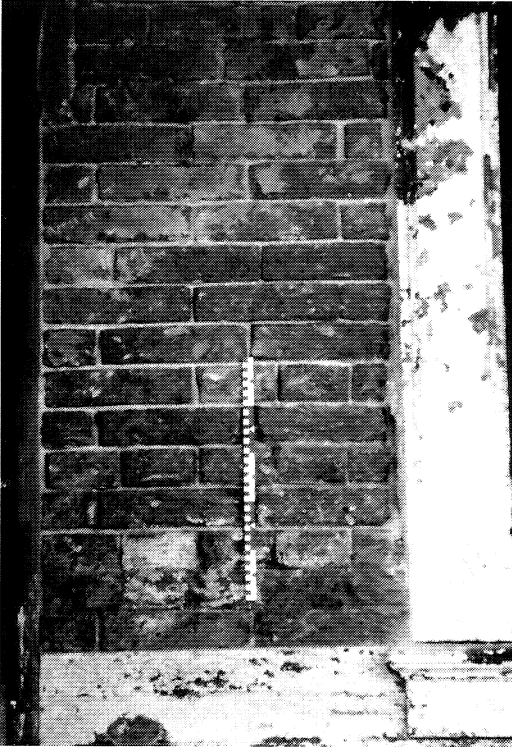
Figura 2 Venezia, Palacio Ducal, vista oeste de edad renacentista: 4 hiladas de ladrillos miden 34,7 cm, exactamente 1 pie veneciano
