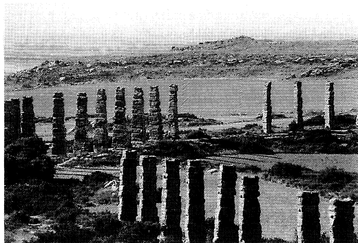
Figura 2 Pilares del Acueducto de Los Bañales
