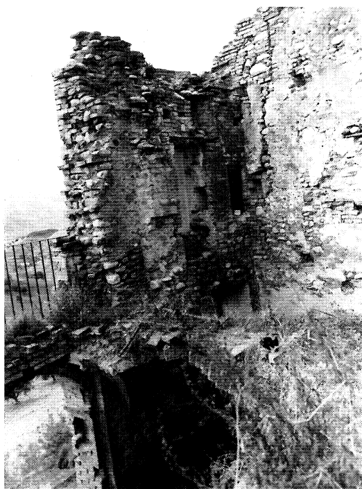
Figura 4 Mampostería realizada con pedriscos de río y ladrillos
