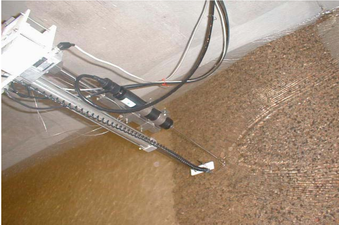
Fotografía 5.8. Aparato de medición de calados y velocímetro ADV
