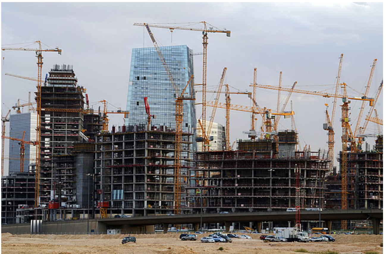
Edificios en construcción en el Centro de la capital Riyadh
