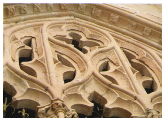
Celosías en arenisca del Bunter en el claustro de la Catedral de Sigüenza. Las dos fotografías de la parte superior muestran el resultado del ataque salino y heladas derivadas de humedades por la escorrentía. En la parte interior, la celosía en zona abrigada aparece exenta de lesiones.
