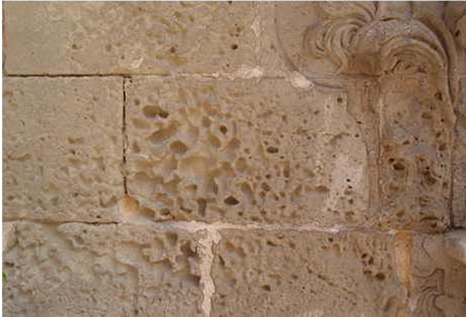
Basílica de Santa María (Alicante.) Este templo está construido con arenisca calcárea y presenta un proceso de descamación y alveolización, debido en gran parte a su proximidad al mar. Diminutas gotas de agua entran en la piedra y al evaporarse cristalizan y la erosionan. .
