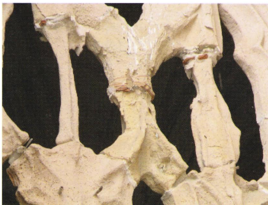
Basílica de Santa María (Alicante.) Este templo está construido con arenisca calcárea y presenta un proceso de descamación y alveolización, debido en gran parte a su proximidad al mar. Diminutas gotas de agua entran en la piedra y al evaporarse cristalizan y la erosionan. .
