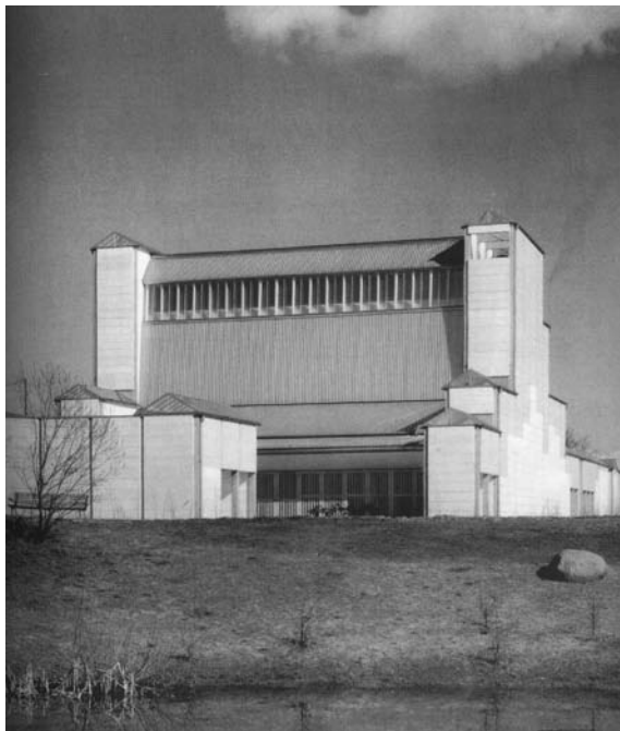
Iglesia de Bagsværd (1968-76), obra de Jørn Utzon. Keld Helmer-Petersen
