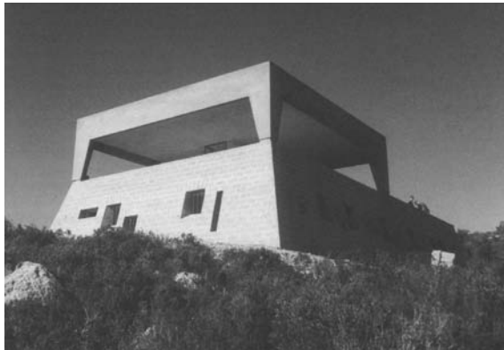
Italesin , 1959-1962, obra de Christian Norberg-Schulz. Fotografía de la fachada sur, c. 1962. Christian Norberg-Schulz
