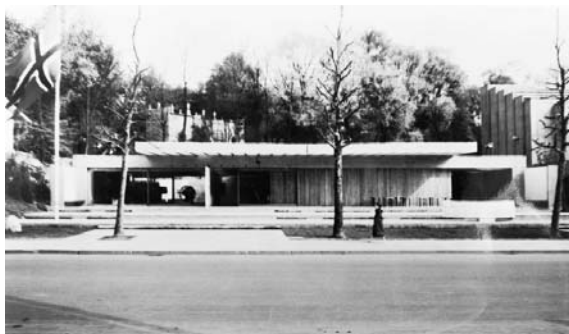
Sverre Fehn, Pabellón Noruego de Bruselas, 1958. A su derecha se distingue el Pabellón Finandés proyectado por R. Pietilä. Teigens Fotoatelier
