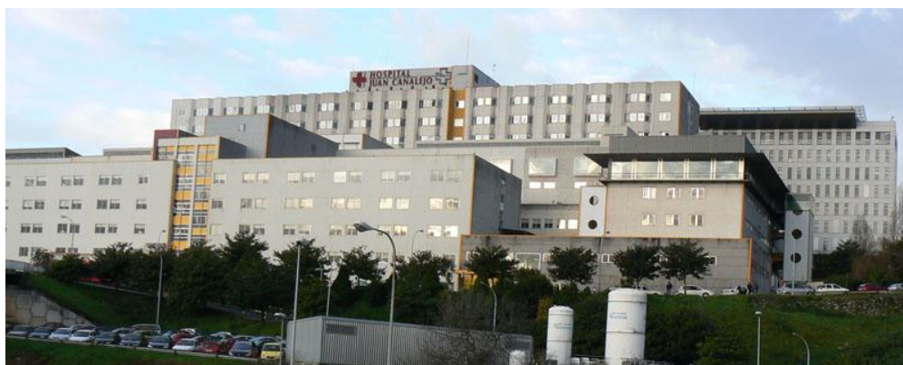
Figura 3. Imagen del Hospital A Coruña
