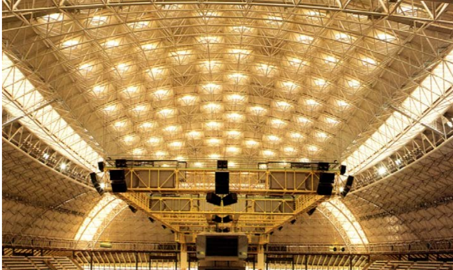
Ilustración 3 - El Palau San Jordi. Barcelona. Fue construido utilizando herramientas CAD/CAM. Fuente: Tesis doctoral José A. Vázquez Rodríguez (4)
