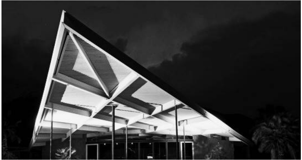
(Fig. 6) Tramway Gas Station, Palm Springs (California). Archivo de los autores.
