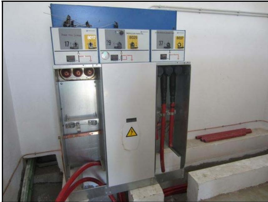
Ilustración 1.8.1.2.1 - Celda compacta existente CGMCOSMOS-2LP
