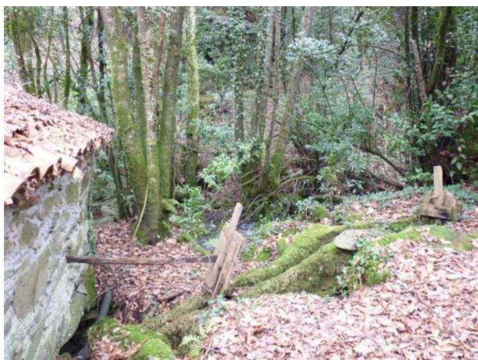
Canal reforzado con piedra que conduce el agua hacia el rodezno. Compuertas de madera para regular el caudal
