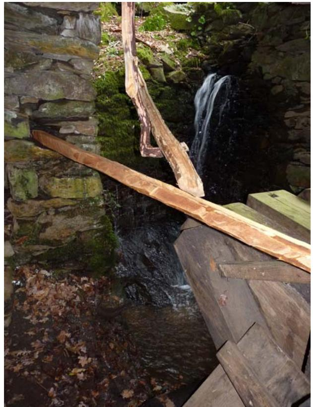
Canal de madera de roble, que conduce el agua de refrigeración de los goznes o gorriones y la empleada para remojar las telas\_
