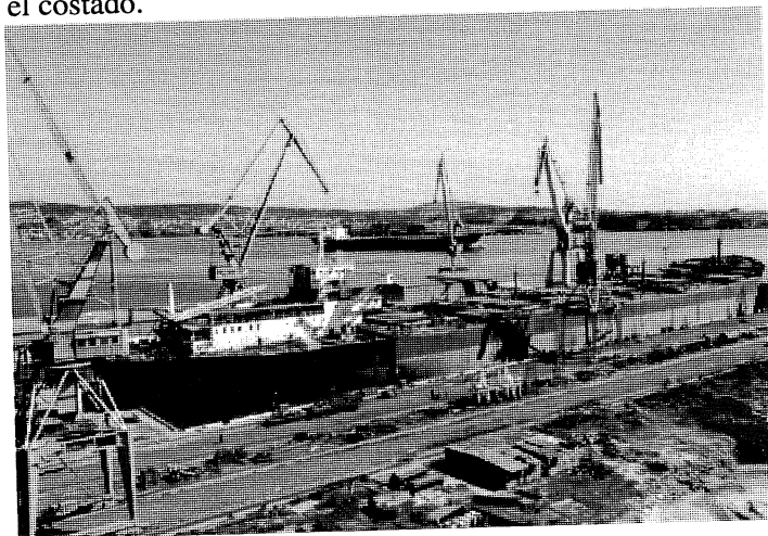
Foto 11.-Nuevo petrolero. Vista de la soldadura en el costado, una vez unido.
