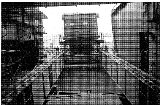
Foto 15.- Caldera de carbón. Vista de la caldera sobre las guías en otro momento de su traslado al interior del buque.
