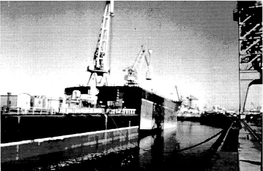
Fotografía R2: Reparación del buque "Knock Ardy". El petrolero "Knock Ardy" de 1.500.000 Tpm sufrió una explosión originada posiblemente por concentración de gases en el tanque de lastre número 1 Estribor. Como resultado de la explosión desapareció prácticamente el forro, la cubierta y el mamparo longitudinal en 80 mts de eslora. Supuso la renovación de 1700 Tns de acero y equipo de tubería , teleniveles, maquinillas, etc. La obra se realizó en 100 días.
