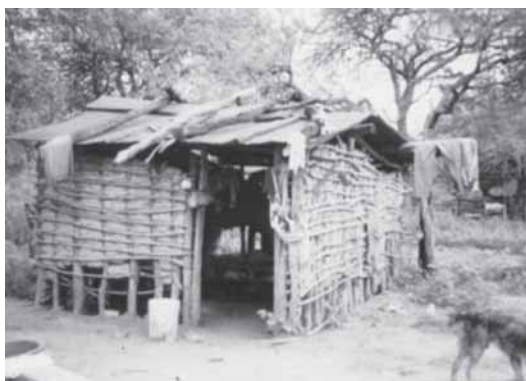
Fig. 1.- Vivienda del grupo I.
