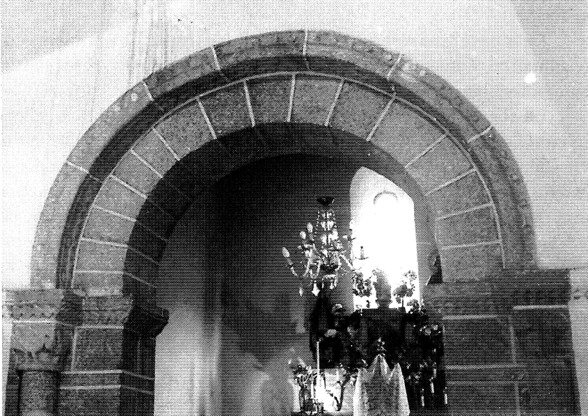
Lám. VI: Fig. 1.- San Miguel de Biville, detalle del soporte izquierdo del arco triunfal. Fig. 2.- San Andrés de Paradela, arco triunfal. (Fotos Archivo Yzquierdo).
