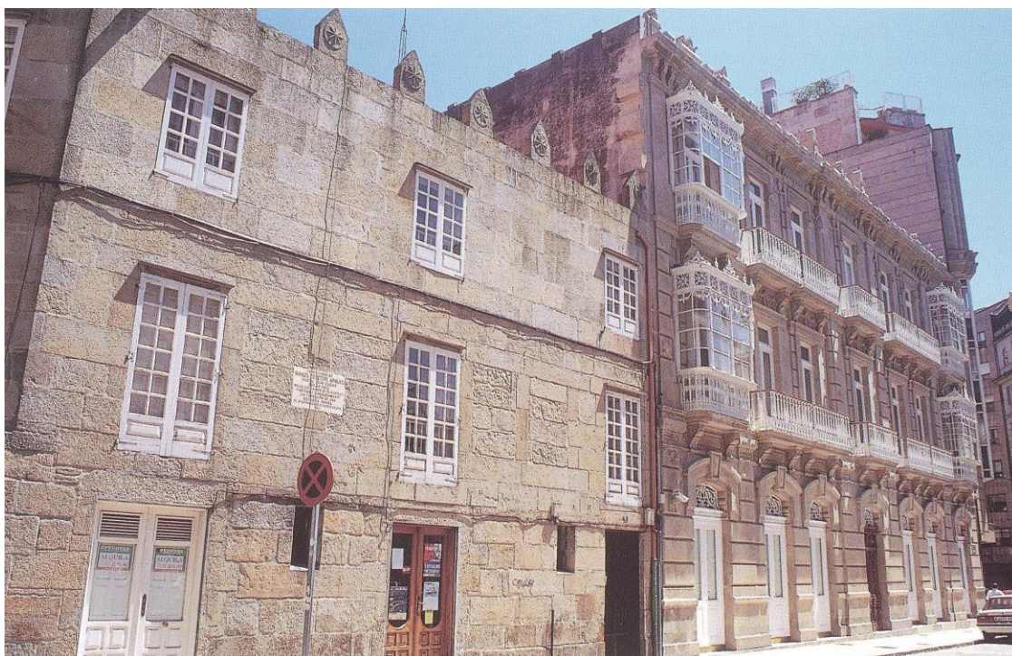
9.- Estado actual del edificio de los Montenegro, ampliado con una planta, en la plaza de San José (foto del autor)
