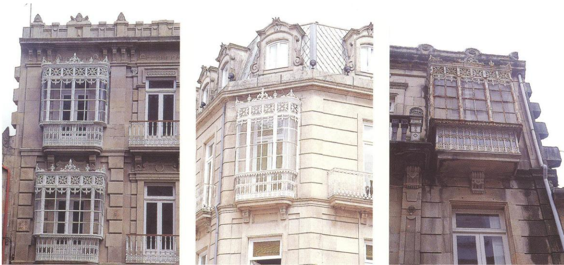
12.- Miradores de hierro en la fachada de la Fundación Caixa Galicia. El mismo modelo de mirador, con un solo módulo en la P Curros Enríquez. Edificio de fachada de cantería y miradores de hierro en la C Oliva (Fotos del autor)
