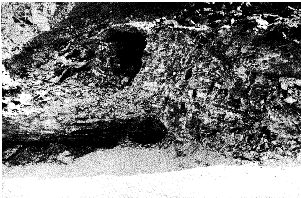
Foto n.º 9. Mina «Alegría». Morille (Salamanca). Galerías de la antigua explotación donde se aprecian, con tonalidades más claras, los niveles calcosilicados.
