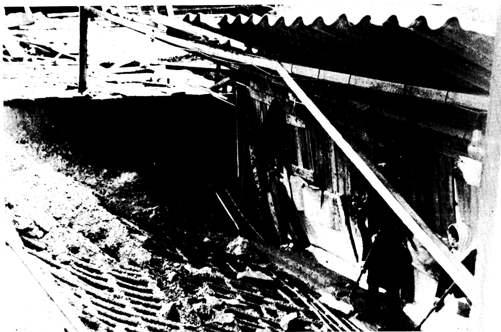
Foto n.º 12. Minerías limpiando la tolva general en la vieja explotación de Santa Comba.
