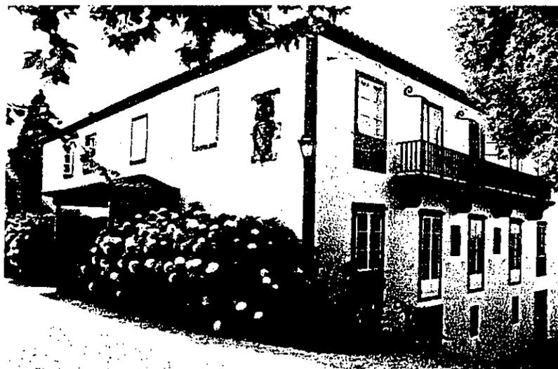
LOS BALCONES PUEDEN SER DE HIERRO FORJADO ARTESANO O COLADO EN LA FUNDICIÓN DE SARGADELOS, CUANDO ESTA MANUFACTURA EMPEZÓ A TRABAJAR. PUEDEN SER TAMBIÉN DE MADERA, CON SENCILLOS BARROTES, O DE PILASTRAS GRANÍTICAS DE FUSTE BARROCO SOSTENIENDO LA BARANDA EN LAS SOLANAS QUE MIRAN AL MEDIODÍA.
