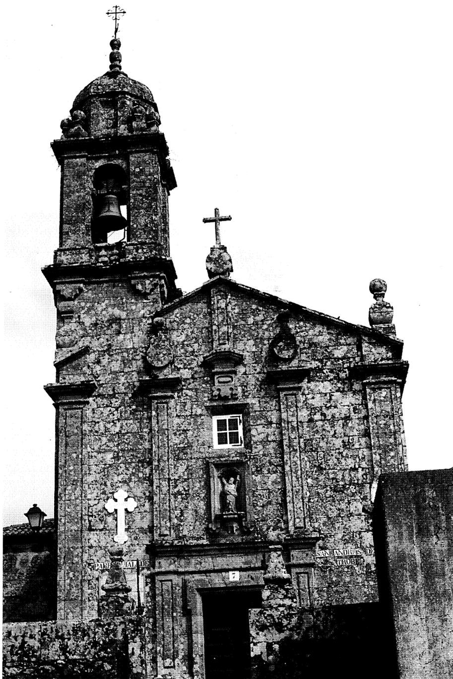
Su planta es una cruz latina siendo los brazos del crucero muy cortos con una sola nave de 19,2 x 5,8 metros que se cubre de madera a tres aguas. El brazo transversal cuenta con dos capillas de 3,9 x 4,8 metros cubiertas con bóveda de cañón. La cabecera recta utiliza como cubierta una bóveda de arista y la sacristía de 4,25 x 5,3 metros se sitúa adyacente a ella cubierta también con bóveda de arista.
