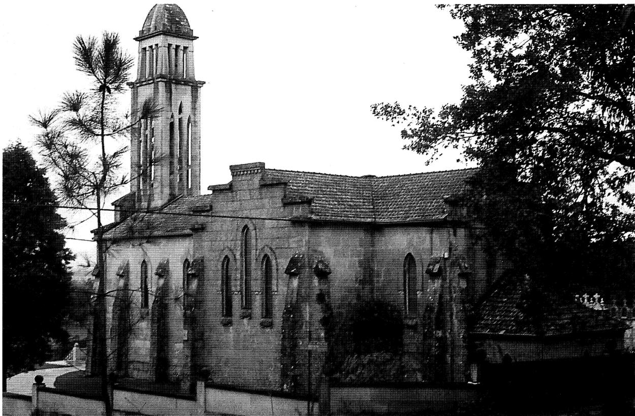
Su planta es una cruz latina cuyo brazo principal lo ocupa una amplia nave de 26,3 metros de largo x 8,3 de ancho cubierta con tres bóvedas de arista apoyadas sobre pilastras, el mismo tipo de cubierta utilizado en la capilla mayor. Dos capillas laterales de 5,10 x 8,3 metros se levantaron a ambos lados del crucero, de nuevo cubiertas con bóvedas de arista, mientras en el crucero se utiliza la bóveda de crucería. La sacristía de 6,9 x 4,3 metros se adosó al presbiterio (Foto 5).
