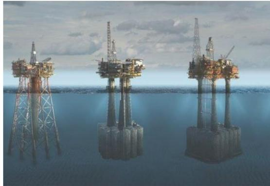
Figura 3.6 Ejemplo de plataformas fijas (Fuente: DrillingFormulas)
