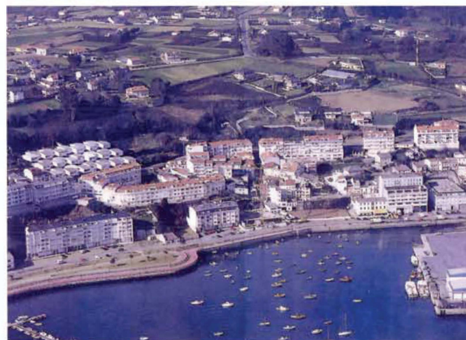
Fig. 4. Imaxe aérea do núcleo de Fontán. Sada, A Coruña (ca. 2009). Á esquerda, o conxunto de 50 vivendas subvencionadas en Fontán-Sada (1967) do arquitecto Andrés Fernández-Albalat Lois, quen recentemente resumía así o proxecto: "Terreno en pendente suave, con vistas al mar (entonces). Ordenación en reticula, vivendas en una o dos plantas, cada tres un jardín, 76m 2 / vivienda. Un "damero" sobre la parcela, surcado por calles que se cruzan. Comunidad y privacidad. La escala del lugar. Respeto del paisaje, del montecillo aquel" (Fernández-Albalat, 2016, páx.: 14).
