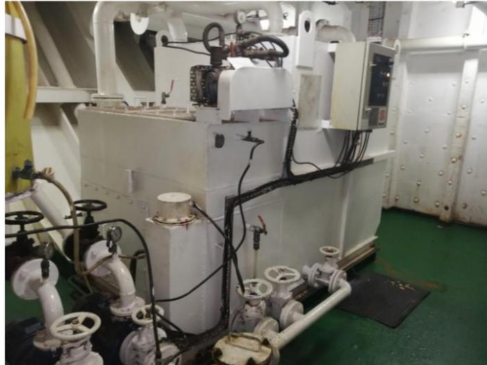
Figura 4.2.2: Planta séptica STP-2. Fuente: Propia.
