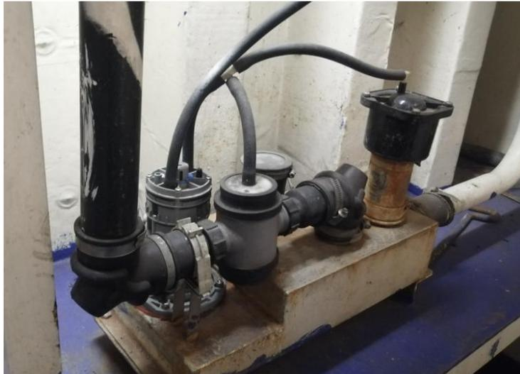
Figura 4.2.3: Caja de vacío independiente. Fuente: Propia.
