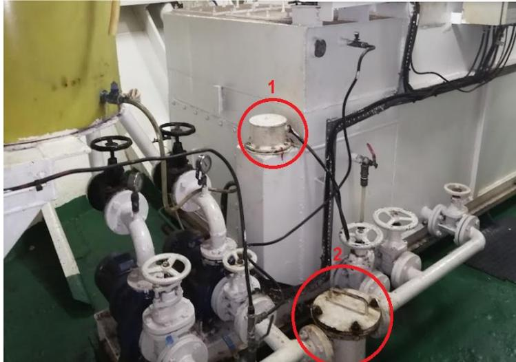
Figura 4.3.1.2.1: Respectivamente sensor de nivel (1) y filtro previo a la descarga (2). Fuente: Propia.
