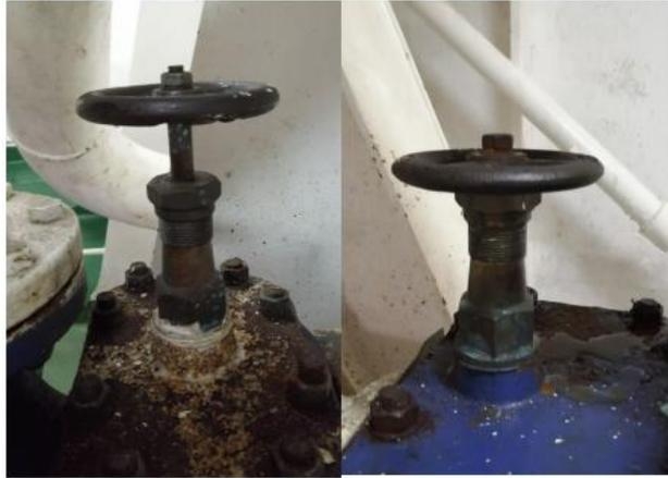
*Figura 4.3.2.2.1:* Respectivamente, Válvula de aguas grises cerrada correctamente y de aguas negras cerrada en mal estado. Fuente: Propia.
