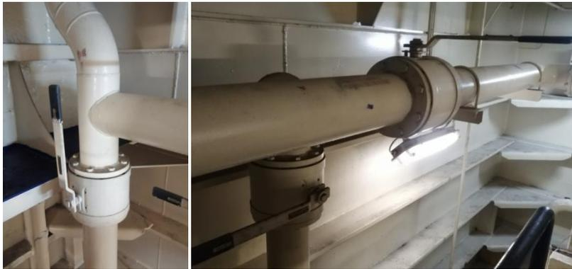
Figura 6.1.1: Entrada de las aguas grises de dilución en la planta. Fuente: Propia.
