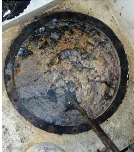
Figura 4.2.2.1.1: Capa de grasa sin desmenuzarse en el tanque de desinfección. Fuente: Propia.
