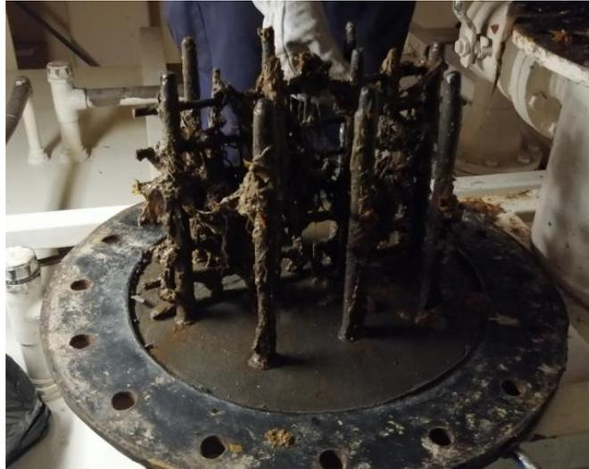
Figura 4.2.1.2.1: Limpieza de los filtros colectores. Fuente: Propia.
