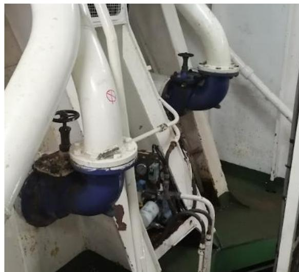
Figura 4.2.2: Válvulas de descarga de aguas negras. Fuente: Propia.
