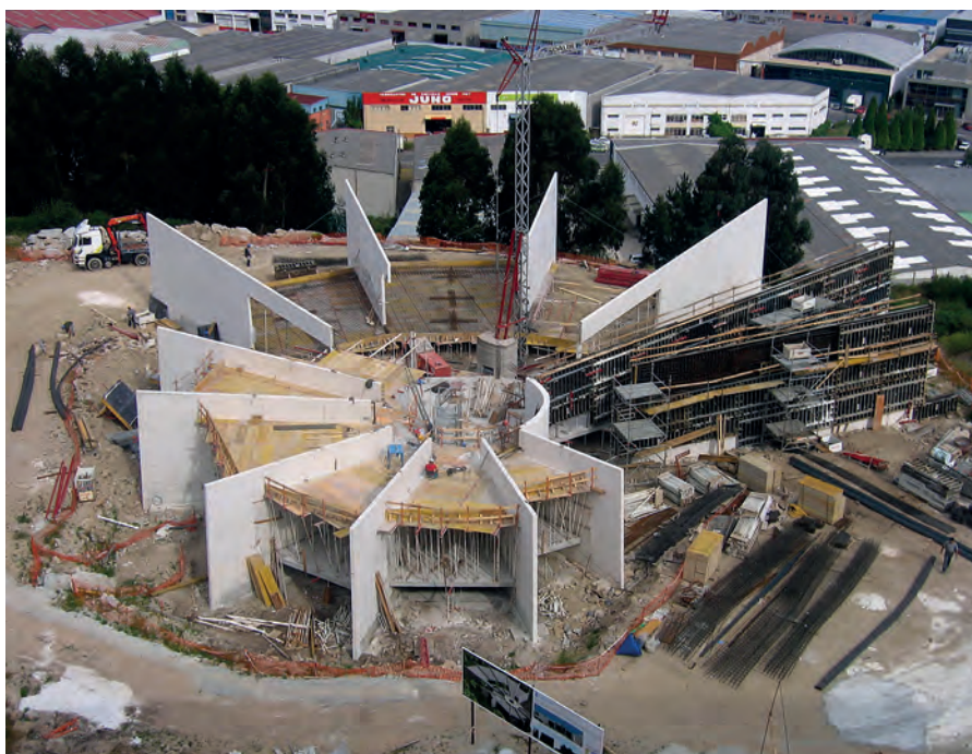
Fig. 04. Escuela Infantil de Mesoiro (2008). Estructura de vigas-pared en fase de ejecución.
