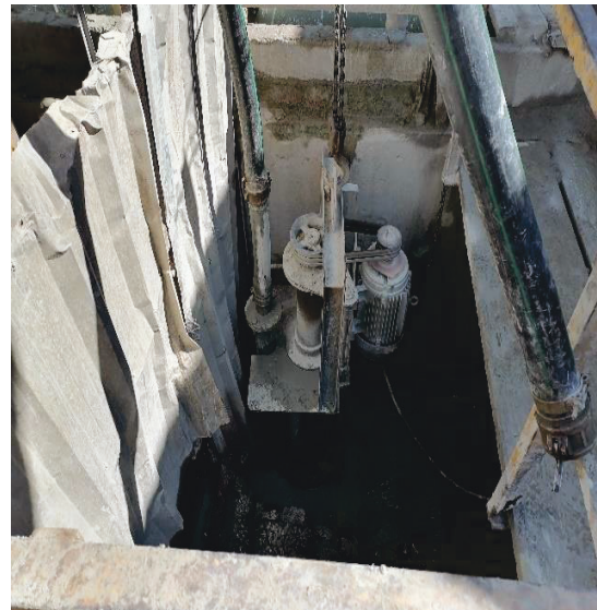
Figura 2.11. Bomba neumática para transporte de material sedimentado
