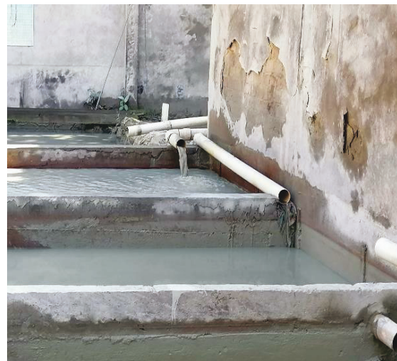
Figura 2.9. Tanques de sedimentación
