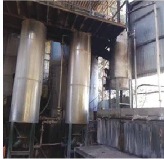
Figura 4.17. Tanque de absorción con geomembrana
