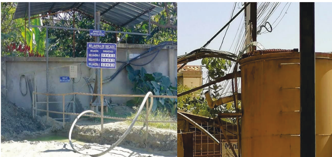
Figura 4.15. Recirculación de agua para el proceso de los molinos
