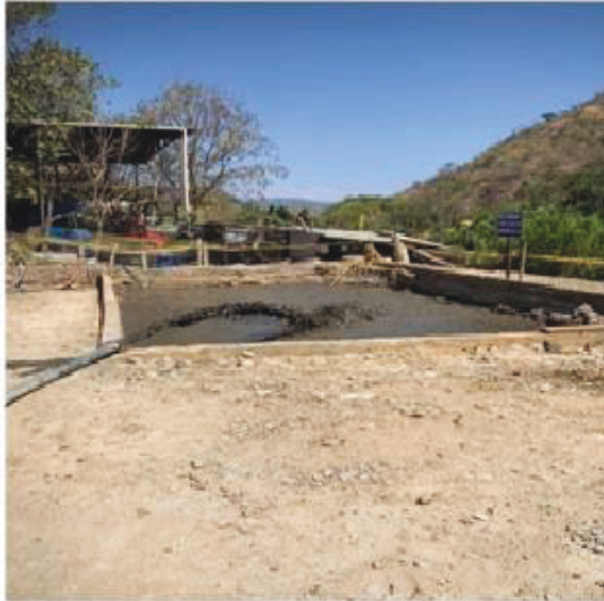
Figura 4.16. Depósito de material cianurado en relave con recubrimiento de geomembrana en el interior
