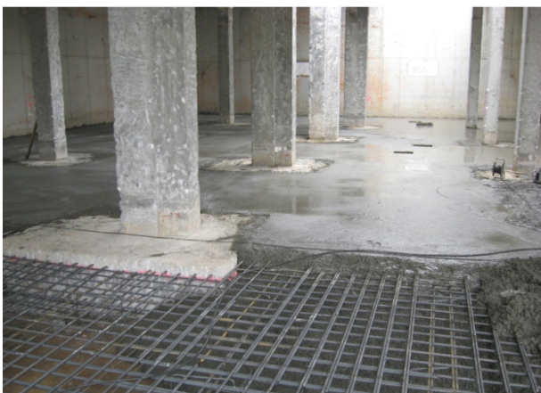
9. Secuencia de recuperación de la cimentación
