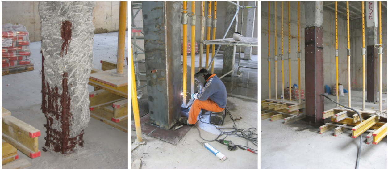
10. Secuencia de pasivado de armadura y recuperación de la capacidad portante de los pilares
