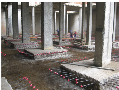
1. Refuerzo de cimentación del C. M. Los Rosales.
