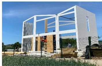
Figura 7. Montaje marcos PB y muros.
