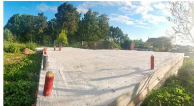
Figura 4. Cimentación solera ventilada.
