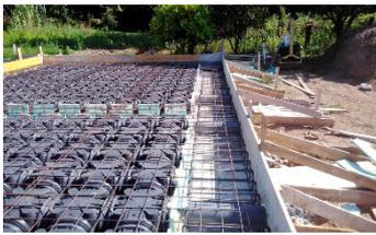
Figura 3. Cimentación armados.
