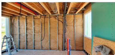
Figura 15. Lana de roca esp. 100 + 65 mm.
