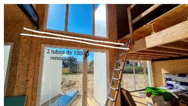
Figura 13. Replanteo conductos de climatización y ventilación.
