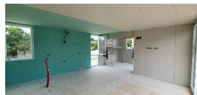
Figura 17. Colocación placas de yeso laminado.
