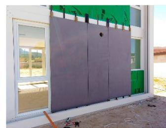
Figura 20. Instalación acabado de fachada.
