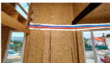
Figura 12. Replanteo instalaciones de fontanería electricidad y teleco.
