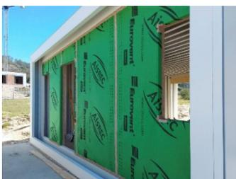
Figura 9. Colocación lámina impermeable en fachada hastial.
