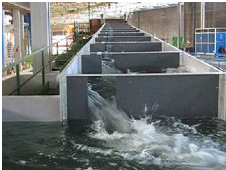
Figura 1: Estructura de una escala de hendidura vertical, ubicada en el Centro de Estudios y Experimentación de Obras Públicas (CEDEX) del Centro de Estudios Hidrográficos (CEH)
