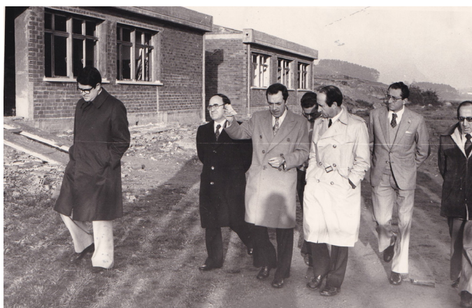
Imagen 5. A Coruña, 1976. Visita a obras de colegios en construcción con el alcalde de la ciudad José Manuel Liaño Flores.
