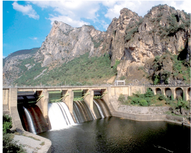
Figura 11. Vista de la presa de Peñarrubia
