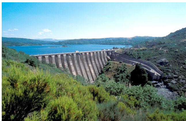
Figura 4. Vista de la presa de Prada
