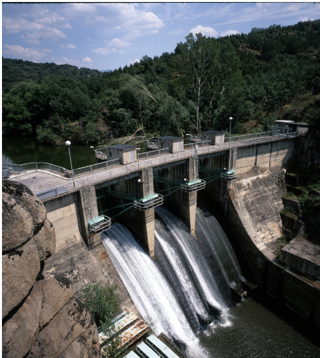
Figura 10. Vista de la presa de Montearenas
