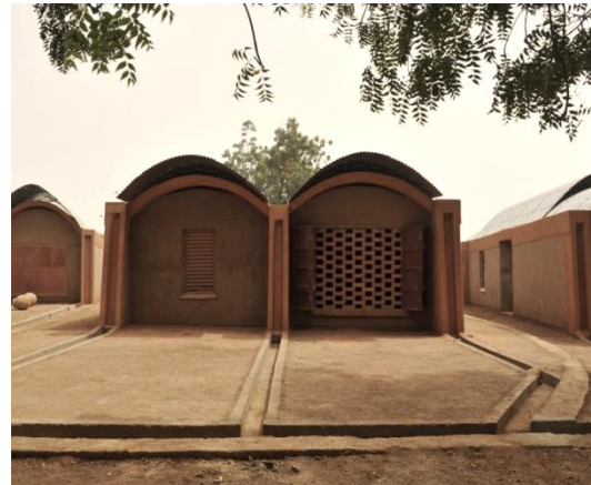
Fig 5.21 Canalización de aguas. Viviendas para maestros en Gando. Fotografía de Erik-JanOuwerkerk.
