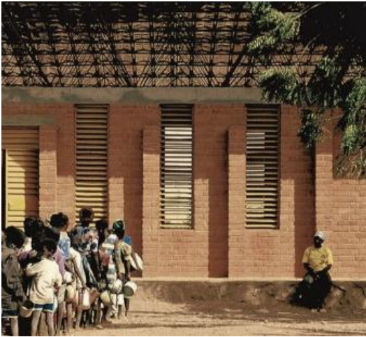
Fig 5.13 Modulación de fachada a partir de los elementos sobresalientes que flanquean los huecos. Escuela primaria en Gando. Fotografía de Erik-JanOuwkerk
