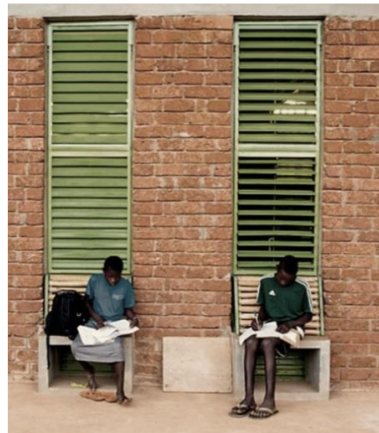
Fig 5.10 Asiento exterior de las ventanas. Liceo Schorge en Koudougou. Fotografía de Daniel Schwartz.
