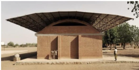
Fig 5.05 Cubierta ventilada. Ampliación de escuela primaria en Gando. Fotografía de Erik-Jan Ouwerkerk.
