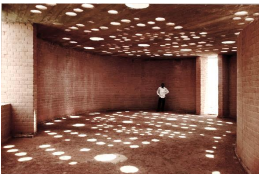
Fig 5.09 Patrón de luces generado por los orificios de ventilación. Biblioteca en Gando. Fotografía de Kéré Architecture.
