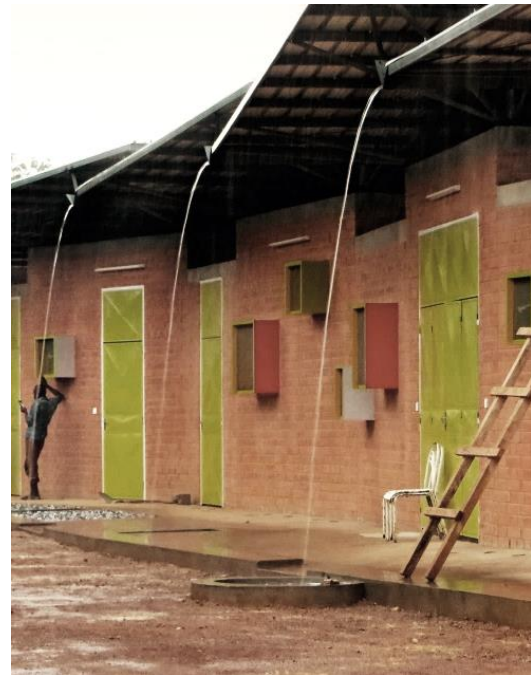
Fig 5.22 Recogida de aguas. Clínica quirúrgica y centro de salud en Léo. Fotografía de Kéré Architecture.
