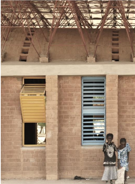
Fig 5.08 Orificios de ventilación del techo. Ampliación de escuela primaria en Gando. Fotografía de Erik-JanOuwerkerk.
