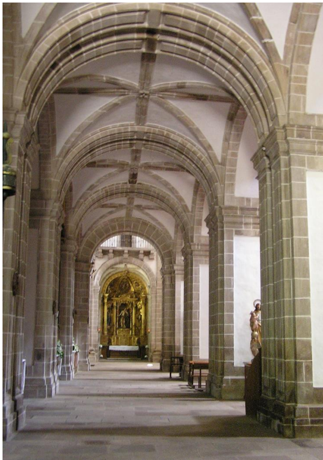
Fig. 19. Bóvedas de crucería simple octopartitas sobre las naves laterales de la iglesia de San Julián de Samos. Medios del siglo XVIII. Foto de la autora
