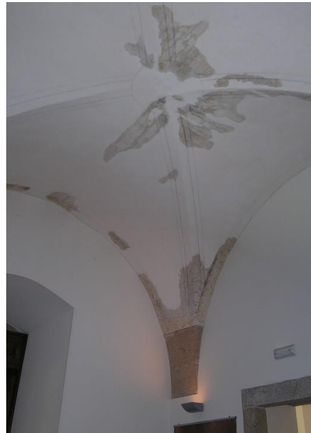
Fig. 3. Bóveda de arista sobre la portería antigua (hoy estancia del museo del monasterio). Hacia 1689. Foto de la autora
