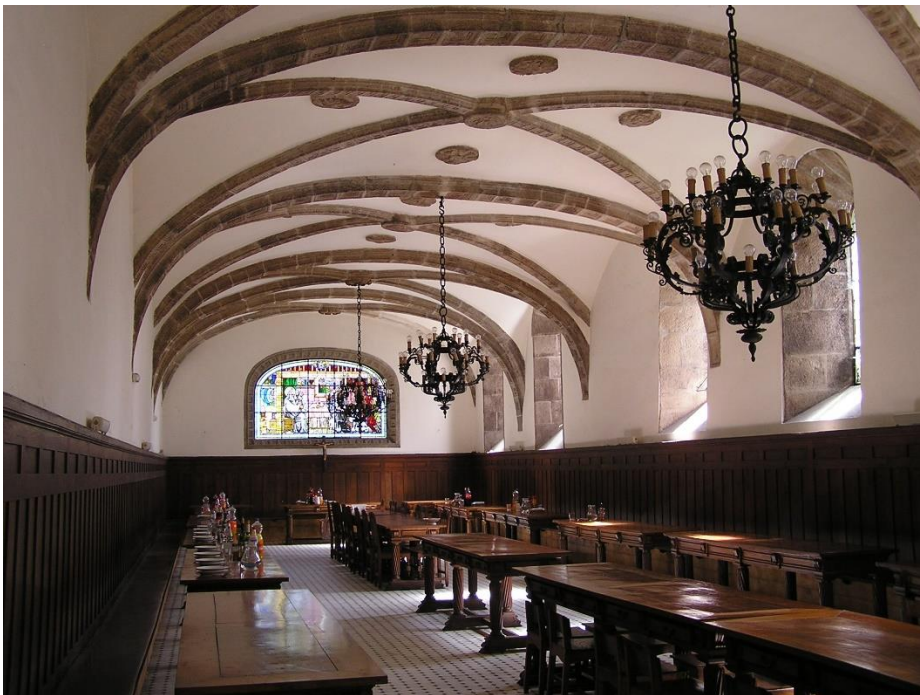
Fig. 15. Bóvedas de crucería del refectorio de los monjes de San Julián de Samos (al fondo, los dos tramos realizados en 1694). Foto de la autora
