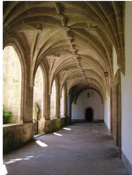
Fig. 17. Bóvedas de crucería del claustro de las Nereidas de San Julián de Samos. 1562-1582. Foto de la autora
