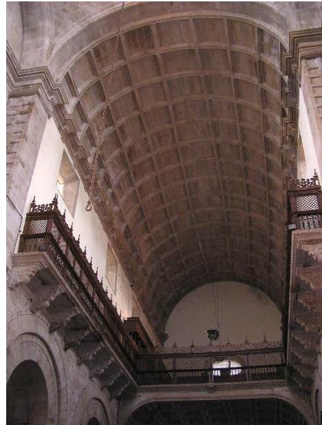
Fig. 7. Bóveda de cañón casetonada sobre la nave central de la iglesia de San Martín Pinario de Santiago de Compostela. Finales del siglo XVI. Foto de la autora
