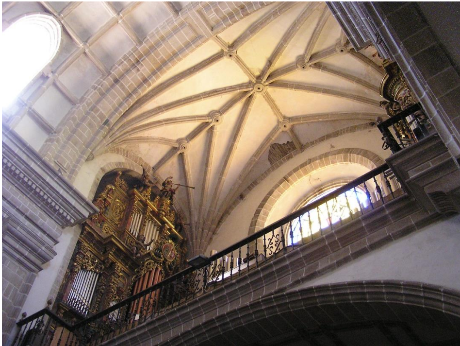
Fig. 20. Bóveda de crucería estrellada sobre el coro alto de la iglesia de San Julián de Samos. Medios del siglo XVIII. Foto de la autora
