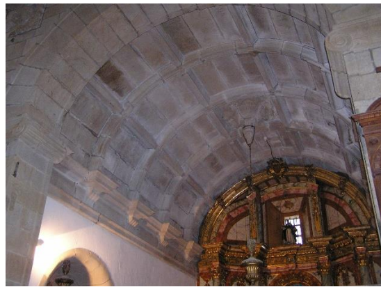
Fig. 13. Bóveda de cañón casetonada de una capilla lateral de la iglesia de San Martín Pinario de Santiago de Compostela. Finales del siglo XVI. Foto de la autora
