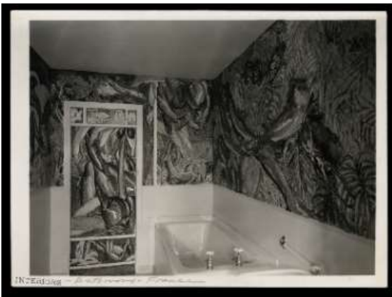
Fig 8 Remodelación baño 2. Residencia Harrison, 1930
