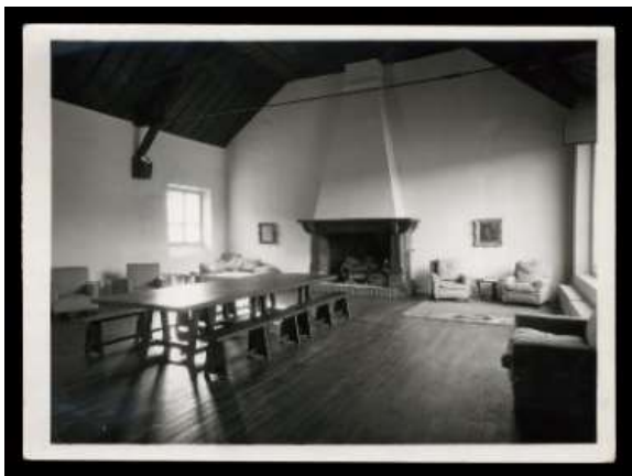
Fig 4 Remodelación comedor residencia Harrison, 1930
