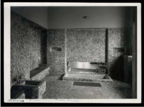
Fig 6 Remodelación baño 1. Residencia Harrison, 1930
