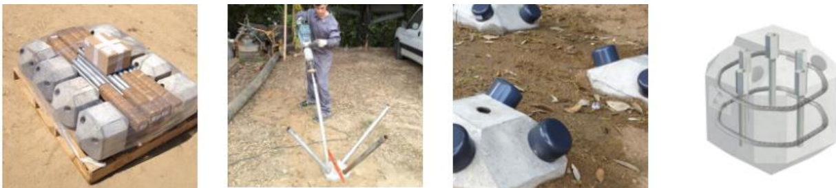
Figura 56: Imaxes do proceso de colocación de un Piloedre. Fonte: https://piloedre.es/
