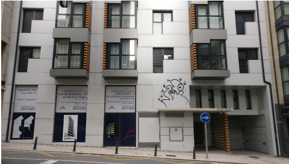
Figura 3. Acceso de fachada
