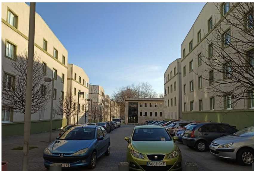
Imagen 4. Rúa Mauro Silva, principal calle del conjunto de Viviendas del Carmen.
