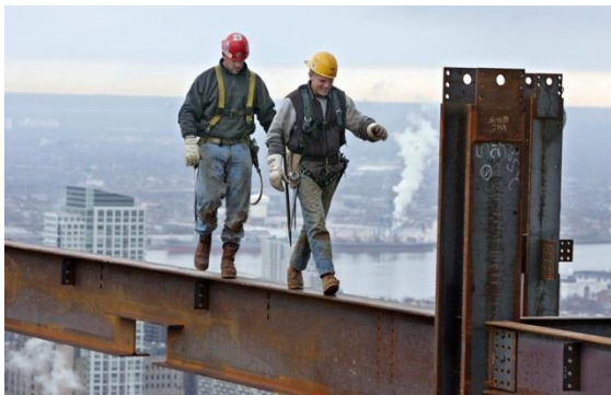
Figura 1: Ejemplo de mal uso de EPP: falta arnés de seguridad y ropa de alta visibilidad.
