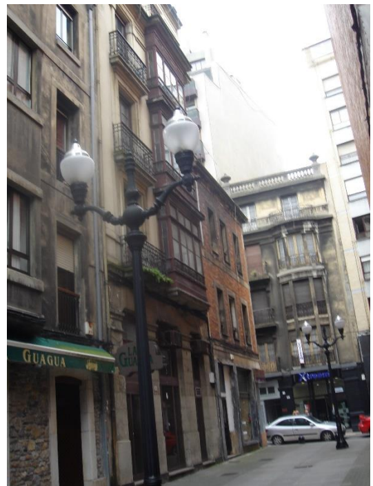
Foto 2. Fachada trasera del edificio, calle Pedro Menéndez.
