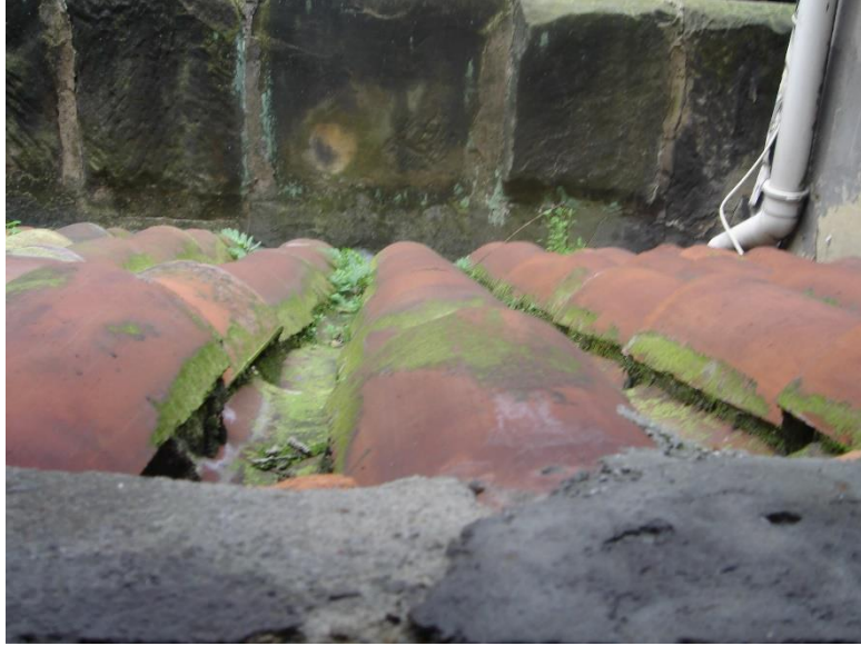
Foto 5. Detalle de cubierta inclinada en la calle Pedro Menéndez.
