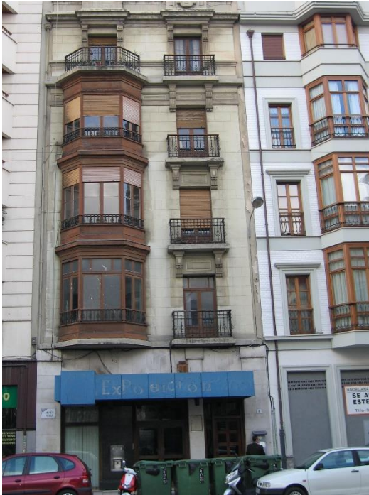
Foto 1. Fachada principal del edificio, calle Menen Pérez.
