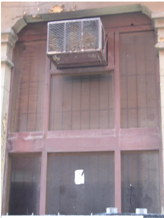
Foto 3. Detalle de la fachada trasera en planta baja.
