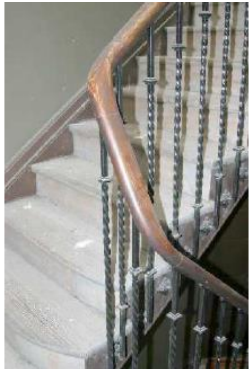
Foto 7. Detalle de escalera en el interior del edificio.
