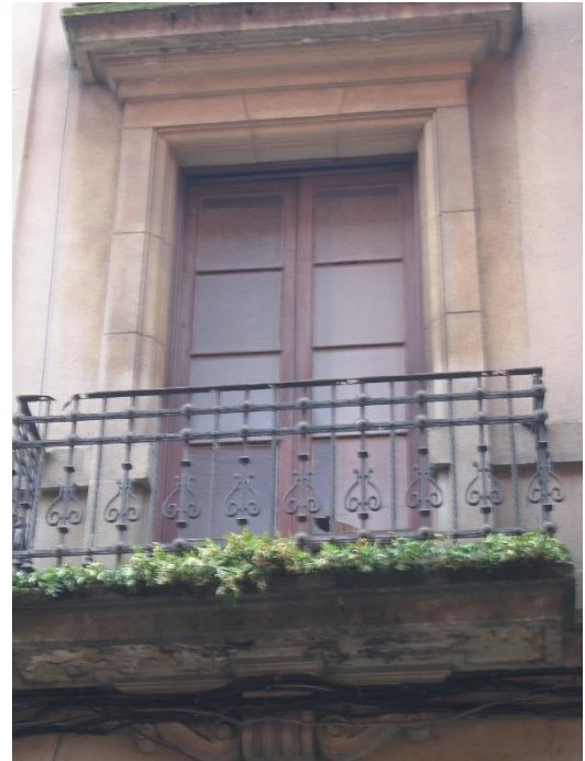
Foto 4. Detalle de la fachada trasera.
