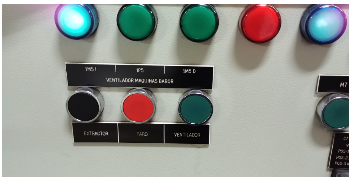
Figura 2.3.8.1- Botonera ventilador máquinas babor. (Original del autor)
