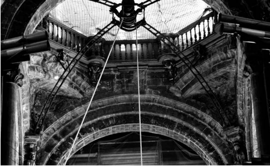
Fig. 8. Trompas del cimborrio gótico y arco de acceso a la capilla mayor. (Archivo R. Yzquierdo).
