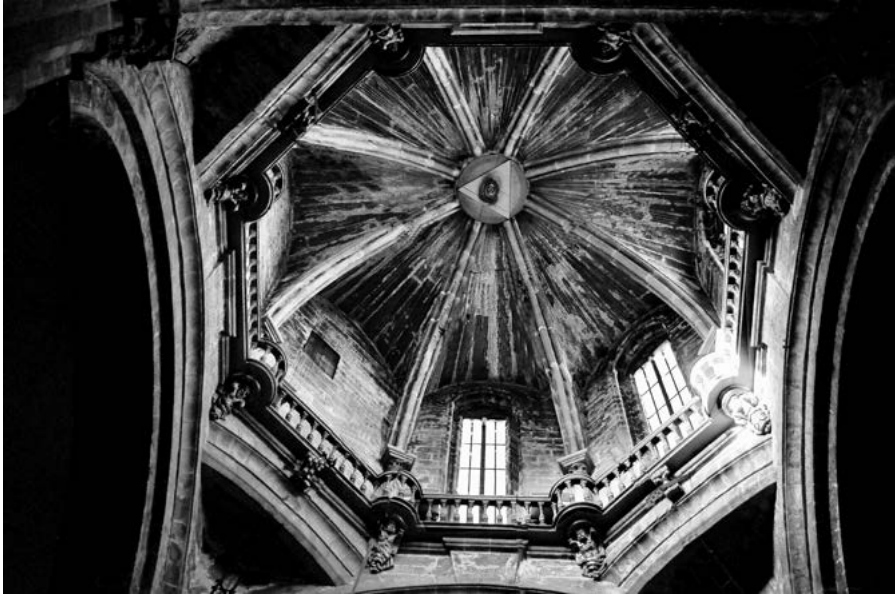
Fig. 6. Conjunto interior del cimborrio gótico y de su bóveda sin el artillugio para el balanceo del Botafumeiro. (Elaboración del Archivo J. Ocaña).
