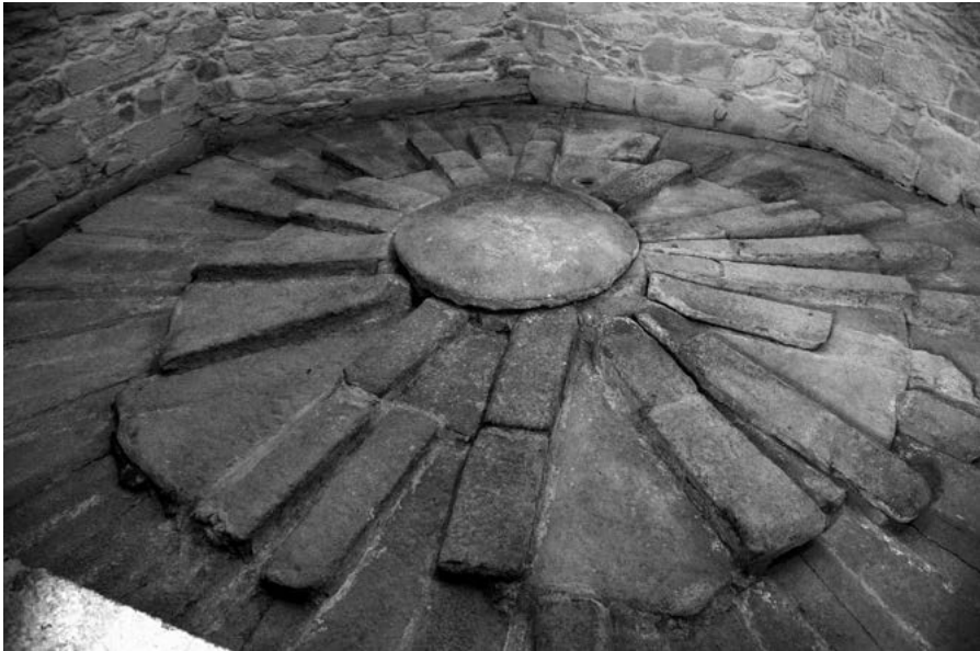
Fig. 11. Cubierta pétreo del cimborrio gótico recuperada durante la restauración realizada entre 2016-2018. (Archivo R. Yzquierdo).
