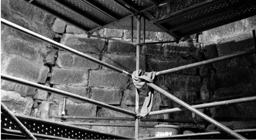
Fig. 20. Detalle del interior de la cúpula del cimborrio en el curso de la restauración de 2016-2018. (Archivo R. Yzquierdo).
