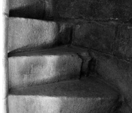
Fig. 10. Escalera de acceso a la cubierta del cimborrio y escalón con basa gótica en su extremo derecho. (Archivo R. Yzquierdo).
