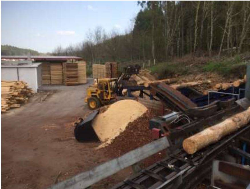
Figura 23: Introducción de troncos por medio de la paleadora en la entrada principal. (Fuente: Elaboración propia)
